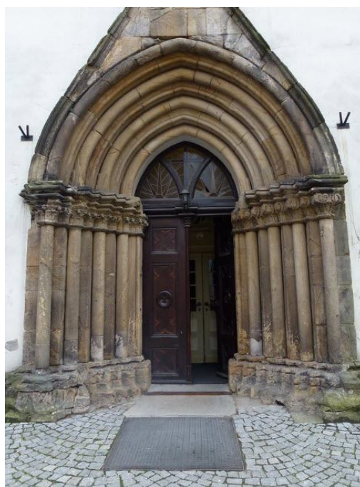
5. Złotoryja, kościół Narodzenia NMP - portal północny, romański portal z czterema parami kolumn o głowicach zdobionych roślinnością
